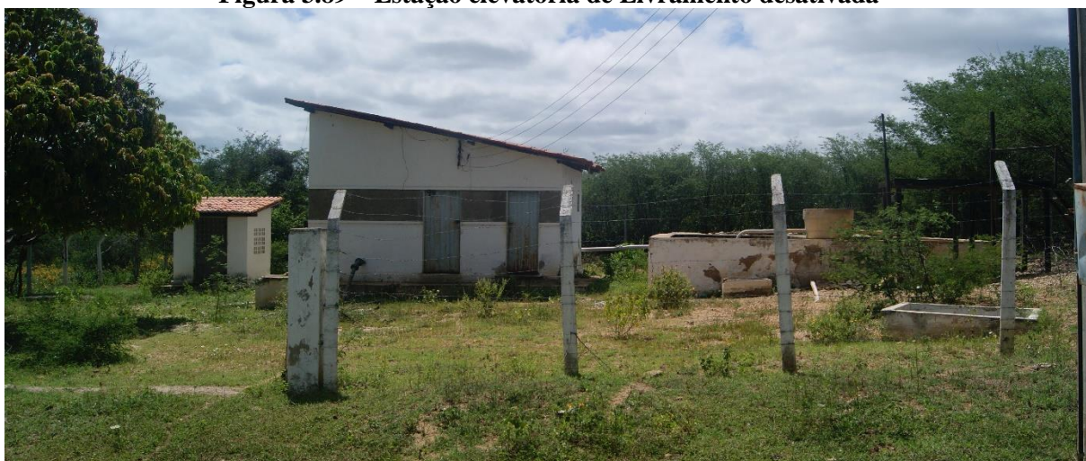
Figura 3.89 – Estação elevatória de Livramento desativada
