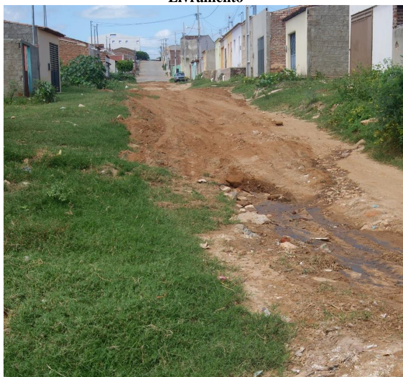
Figura 3.134 – Esgotos sanitários escoando juntamente com águas pluviais na cidade de Livramento
