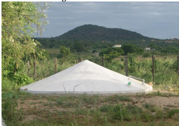
Figura 3.94 – Cisternas individuais utilizados no SAA de Livramento
