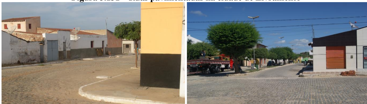
Figura 3.131 – Ruas pavimentadas na cidade de Livramento
