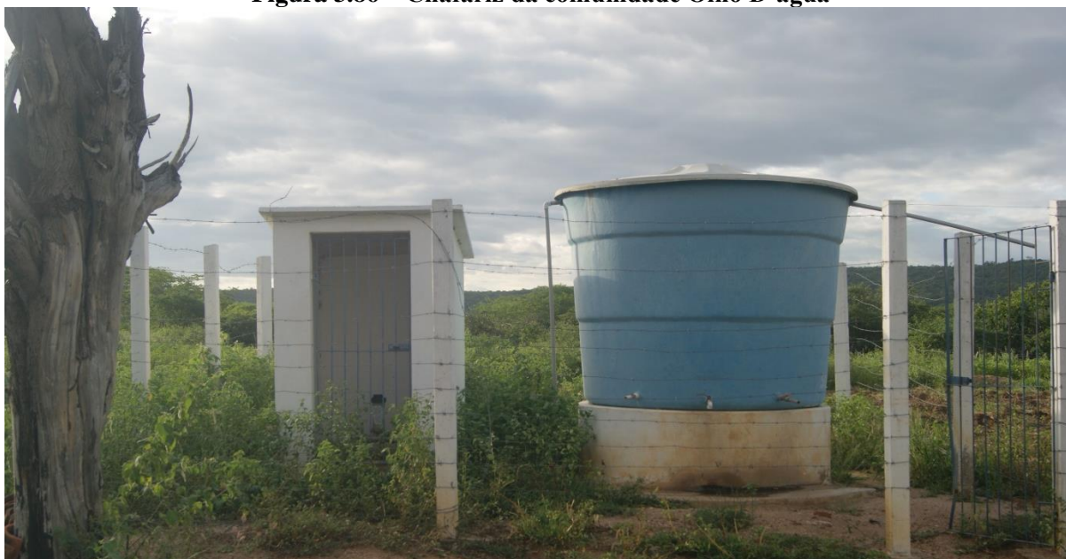
Figura 3.86 – Chafariz da comunidade Olho D'água
