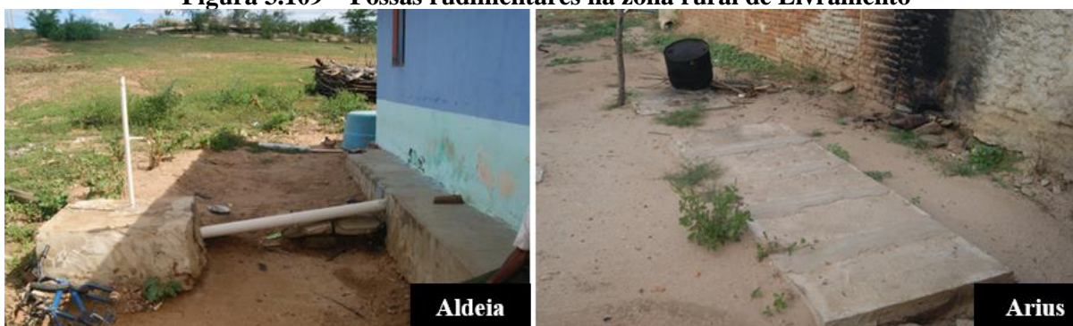
Figura 3.109 – Fossas rudimentares na zona rural de Livramento
