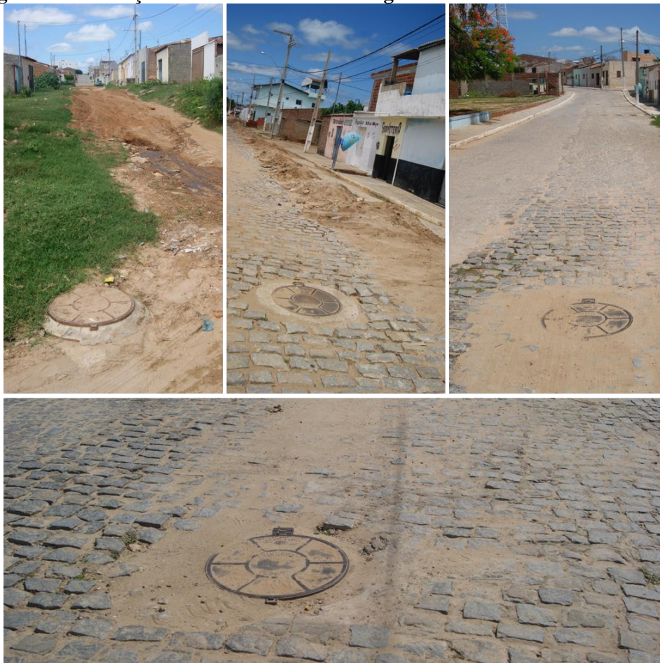
Figura 3.101 – Poços de visita do sistema de esgotamento sanitário de Livramento
