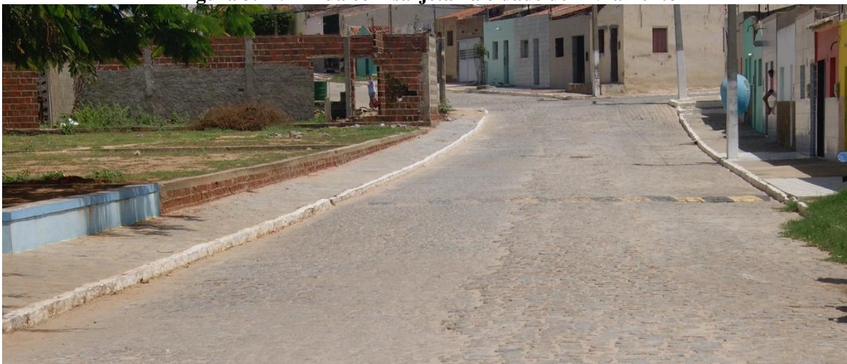
Figura 3.125 – Rua com sarjeta na cidade de Livramento
