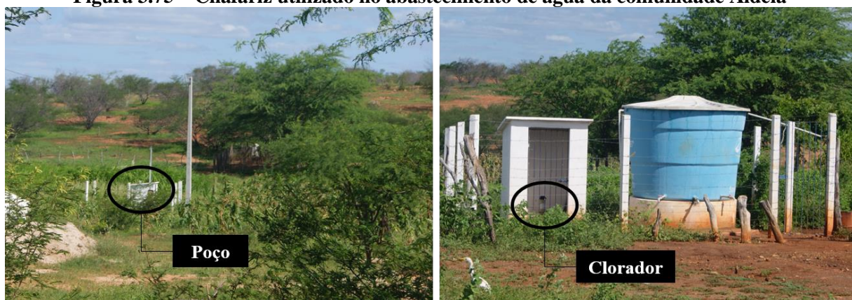
Figura 3.75 – Chafariz utilizado no abastecimento de água da comunidade Aldeia
