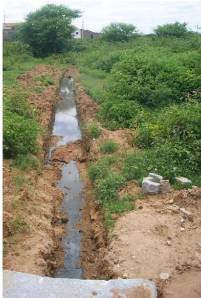
Figura 3.103 – Canal aberto da rua Teodomira Ferreira Portela
