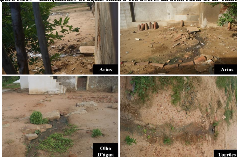
Figura 3.110 – Lançamento de águas cinza a céu aberto na zona rural de Livramento
