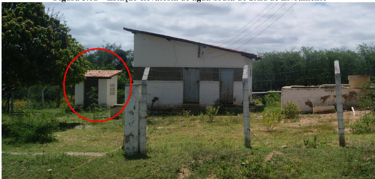
Figura 3.61 – Estação elevatória de água bruta do SAA de Livramento
