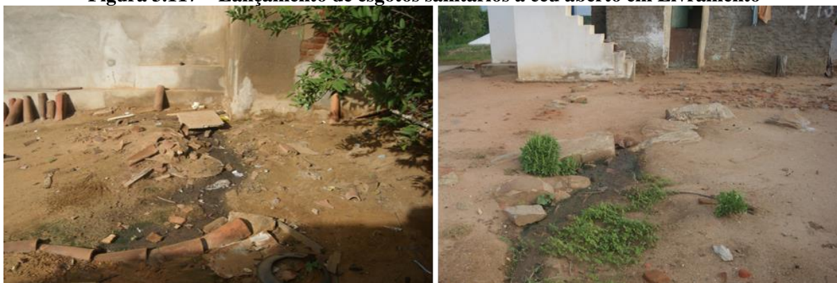
Figura 3.117 – Lançamento de esgotos sanitários a céu aberto em Livramento
