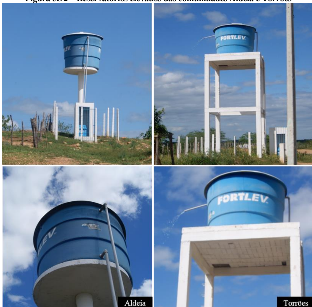
Figura 3.92 – Reservatórios elevados das comunidades Aldeia e Torrões
